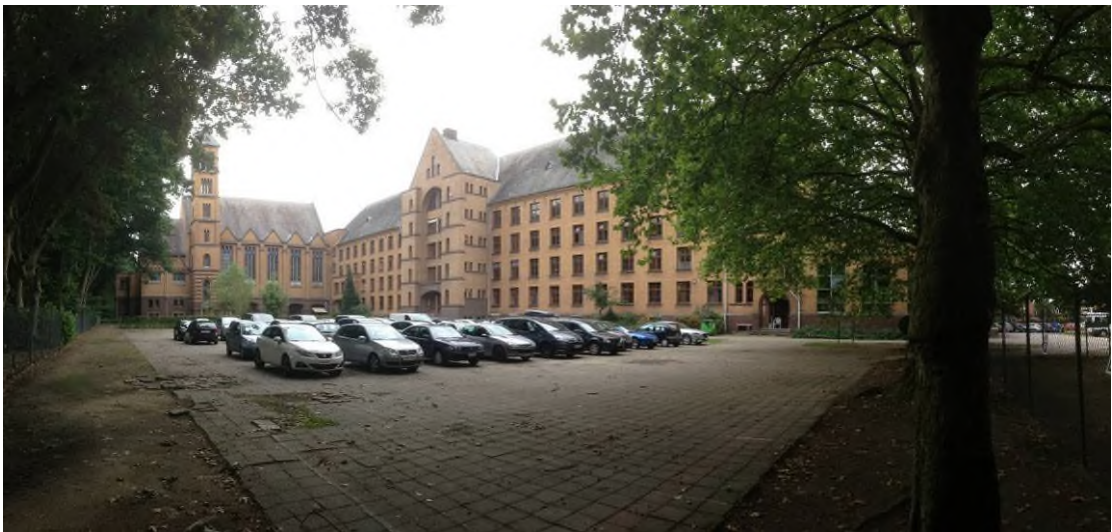
Figuur 2-6 Zorginstelling Borgerstein, achterzijde gebouw
