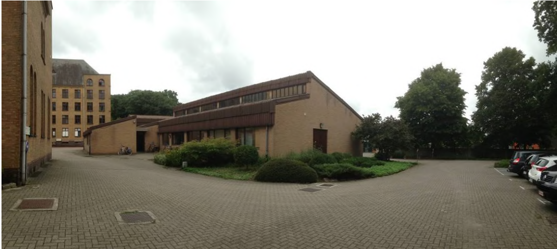
Figuur 4-9 Bijgebouw gebouw Borgerstein – montageplaats (3)
