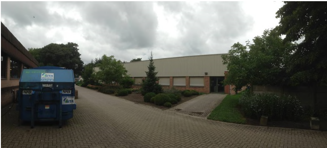
Figuur 4-10 Bijgebouw gebouw Borgerstein – beschutte werkplaats (2)
