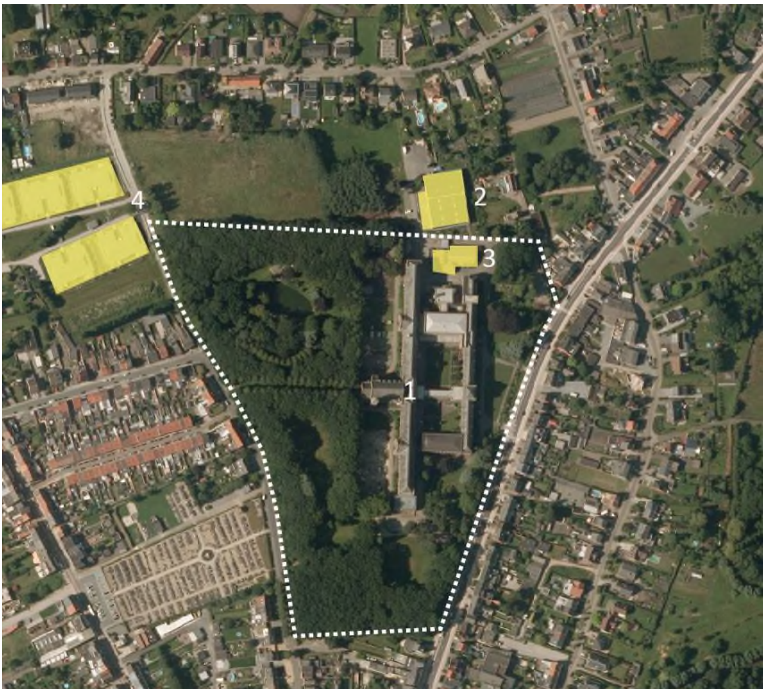
Figuur 4-8 Bebouwing in aansluiting met gebouw Borgerstein (verklaring nummering in tekst).
